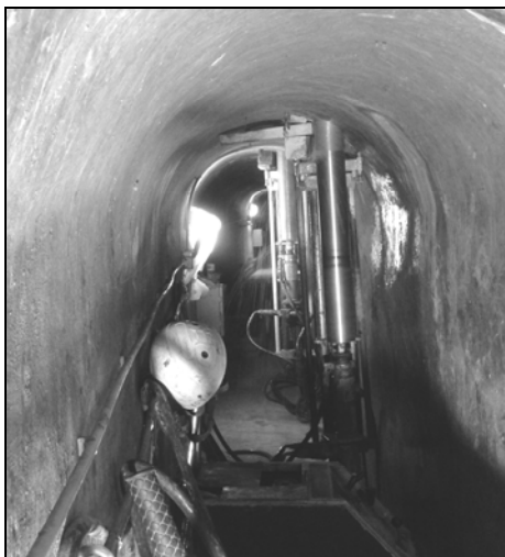
Figura 9 – Carotatrice utilizzata nei cunicoli orizzontali per la perforazione delle canne drenanti \Phi 120
