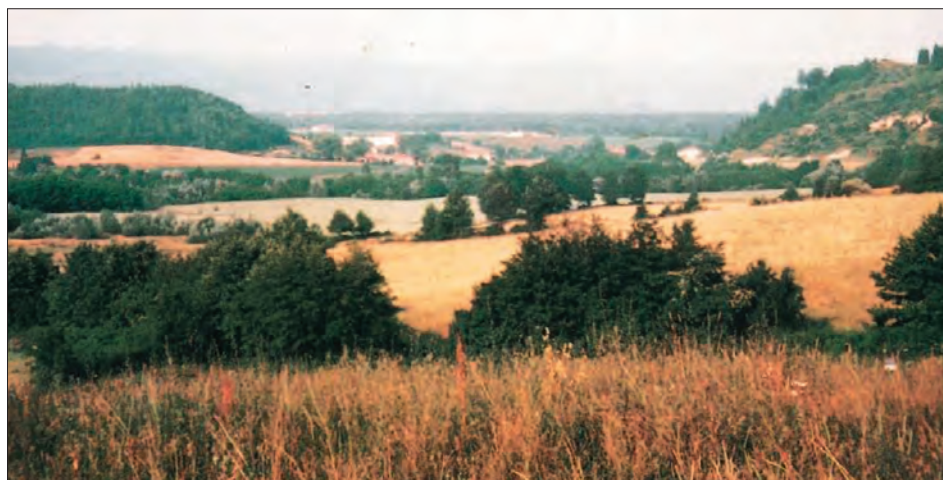
Figura 3 - La stretta della diga delimitata dal Poggio Campiano sulla destra e dal Poggio Mausoni sulla sinistra.
