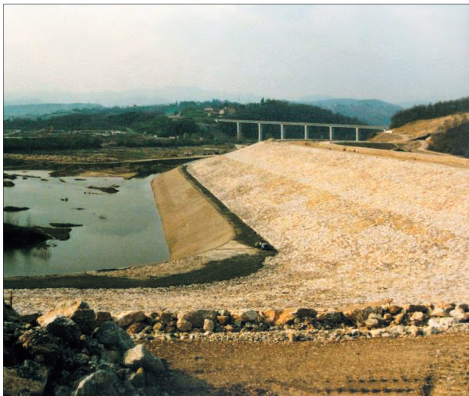
Figura 7 - Placcaggio in destra e paramento di monte (sullo sfondo il nuovo viadotto della SS della Futa).
