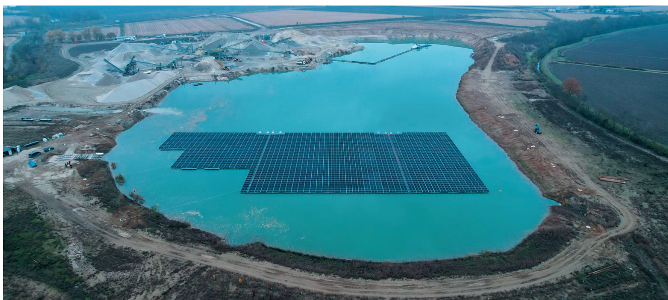
Impianto da 1 MWp realizzato a Ferrera Erbognone (PV) per conto della Inerti Rivolta s.r.l. (Società del Gruppo Gavio). L'impianto è entrato recentemente in esercizio ed è a servizio della cava per i propri consumi.
