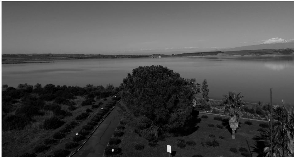
Figura 1. Invaso di accumulo idrico
