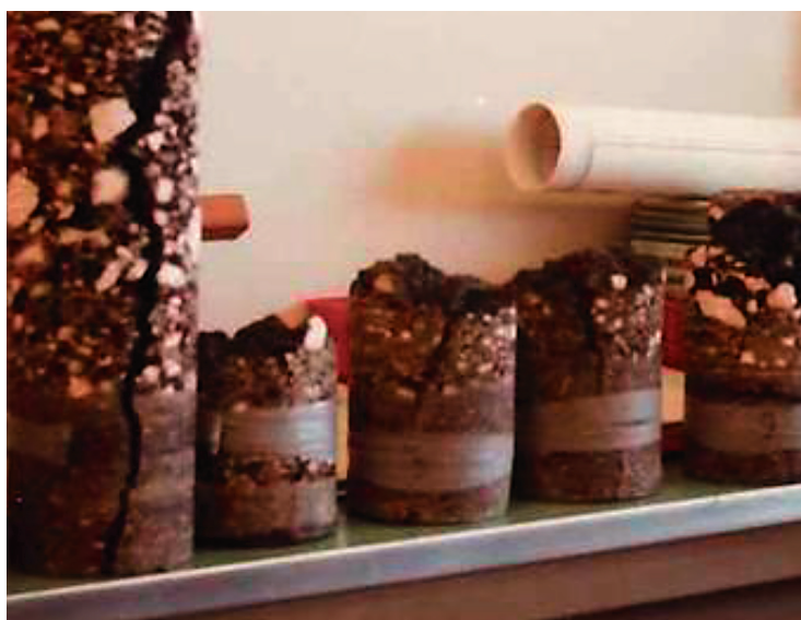
Figura 5 - Caratteristiche delle fessure del manto impermeabile osservate sulle carote.
