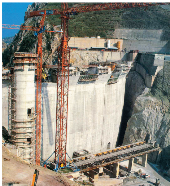
Figura 23 - Diga in costruzione.
