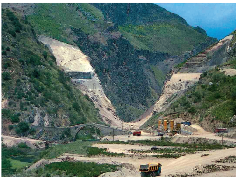
Figura 21 - Scavi diga visti da monte.
