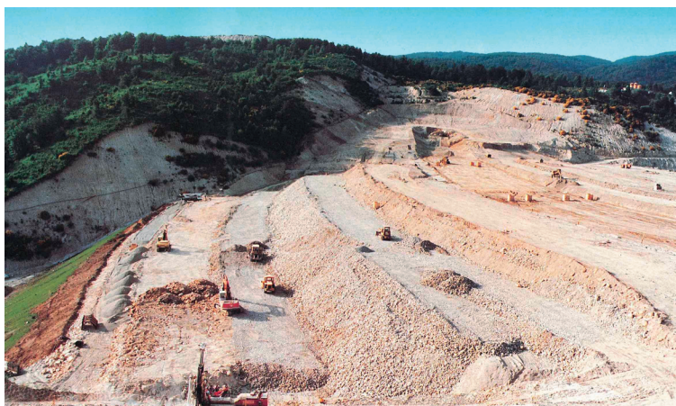
Figura 29 - Rilevato diga in avanzata costruzione.
