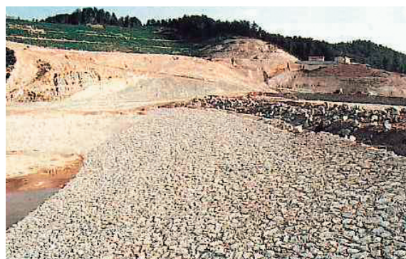
Figura 22 - Scogliera per il paramento di monte.
