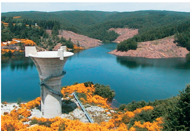
Figura 16 - Calice dello scarico di superficie.
