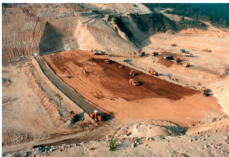
Figura 28 - Posa e compattazione del nucleo.
