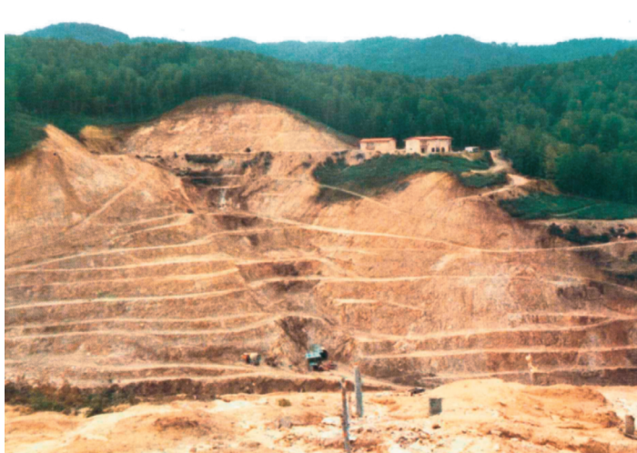
Figura 10 - Scavi in sponda sinistra della diga.
