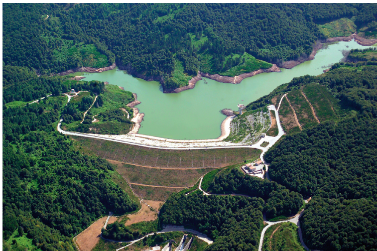
Figura 31 - Vista della diga e del serbatoio con invaso parziale.
